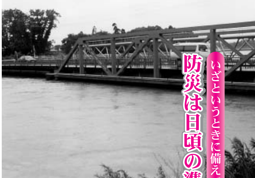
—平成12年・台風3号による増水 寺崎南川橋—
